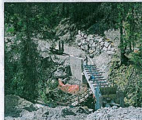
Baustelle oberhalb der Zentrale Felsbach.
