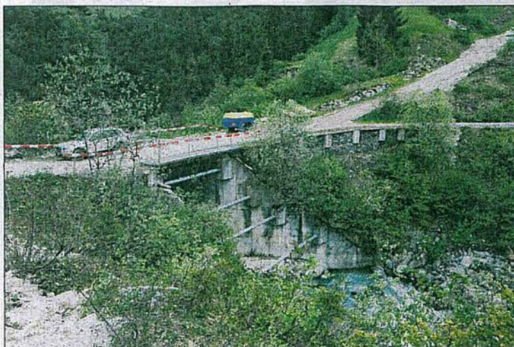
Die Brücke Tarschlims wird aus Sicherheitsgründen ersetzt. Davon profitiert auch der Tourismus – die Skipiste führt über diese Brücke.
