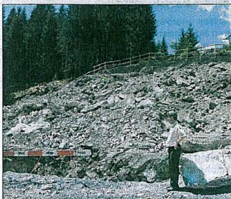
Baustelle der Zentrale Punt Gronda – im Hintergrund die 16 Meter hohe Ankerwand mit 1500 Felsankern.
