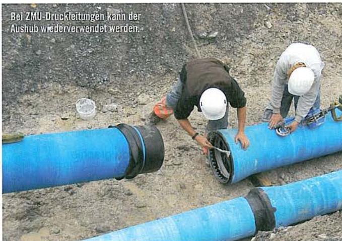
Beim Großprojekt Wasserwelten Flims wurden ZMU-Vollschutzhohre in den Nennweiten DN 300, DN 400 sowie DN 500 verlegt.
