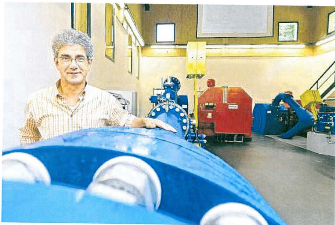
Wo 500 Liter pro Sekunde durchrauschen: Flims-Electric-Direktor Martin Maron zeigt in der neuen Zentrale Felsbach das Ende der Druckleitung mit dem Karstwasser aus dem Umfahrungstunnel.
