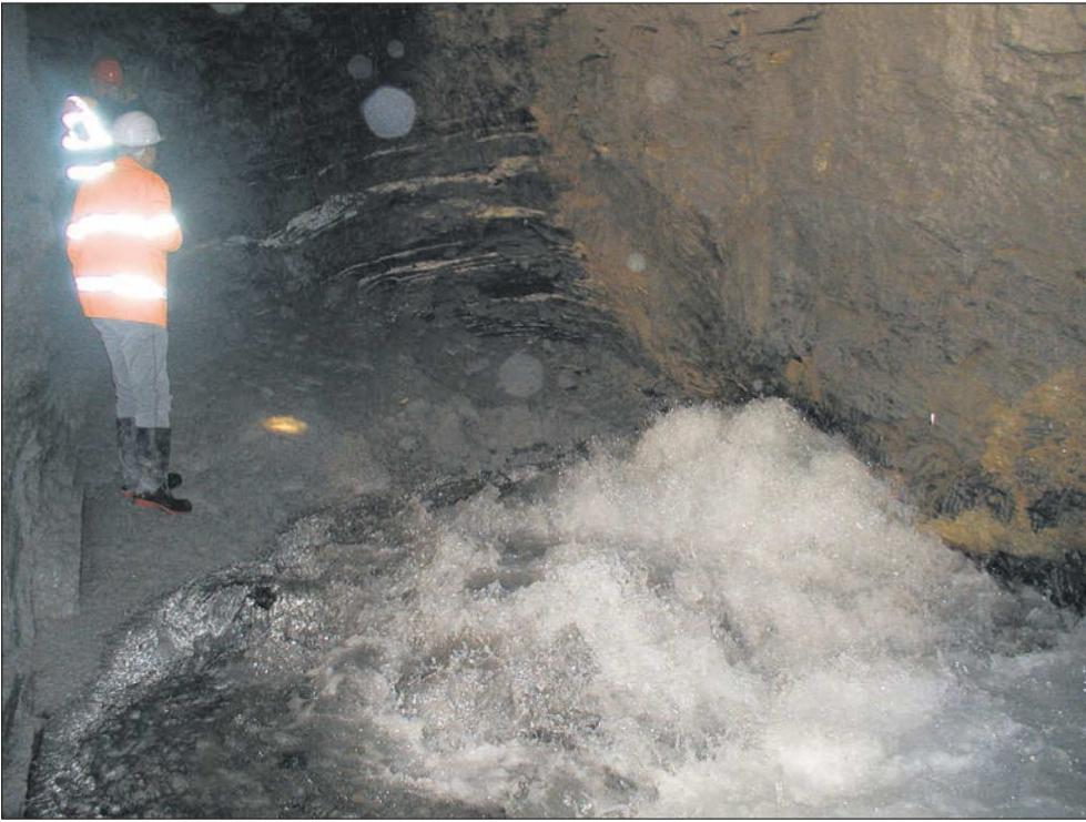
1. Oktober 2002: Im Zug der Tunnelbauarbeiten wird ein Karstsystem angeschnitten.
