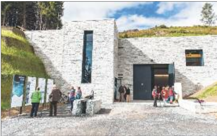
Das Herz der Sinfonia d'aua: die Wasser- und Energiezentrale Punt Gronda mit einem multimedial gestalteten Besucherraum.
