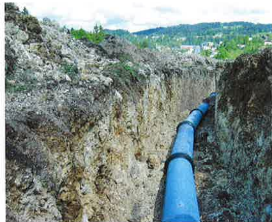
Duktile Gussrohre nehmen hohe statische Belastungen aus Innendruck, Verkehrslasten und Erdaufasten auf.
