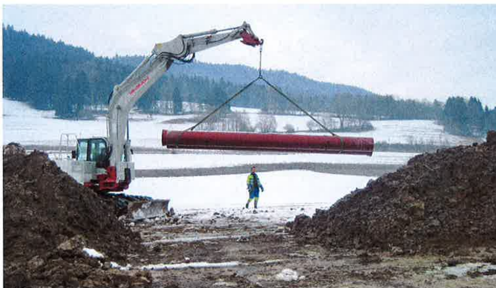
Duktile Gussrohre haben hohe Druckreserven und können bei jedem Wetter eingebaut werden.
