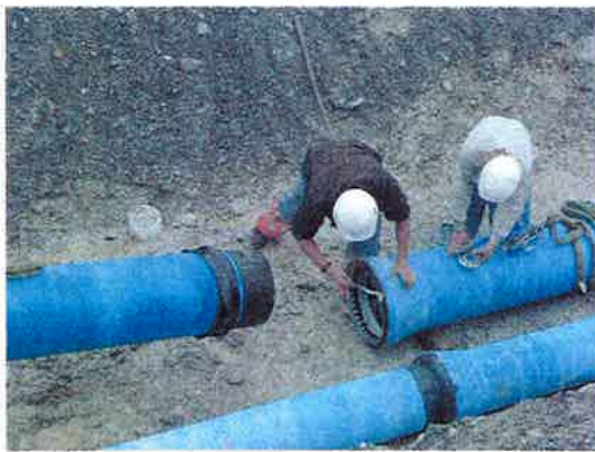
Mit der TIS-K-Verbindungstechnik sind ZMU-Rohre schnell und effizient über 360° am gesamten Rohr anliegend schubgesichert. Besonders geschätzt wird die rasche und sichere Montage.
