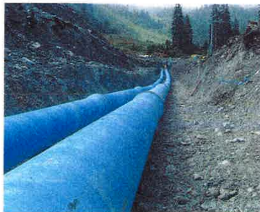
Die 4660 m lange ZMU-Turbinenleitung DN 500 ab der Wasserfassung Segnas ist für 78 bar ausgelegt.
