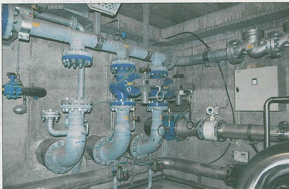
Die im Rahmen des Projekts Wasserwelten Flims erweiterte Steuerungszentrale der Beschneigungsanlagen in Punt Gronda. Links im Bild der vorbereitete Abgang für die Beschneigung Foppa.
