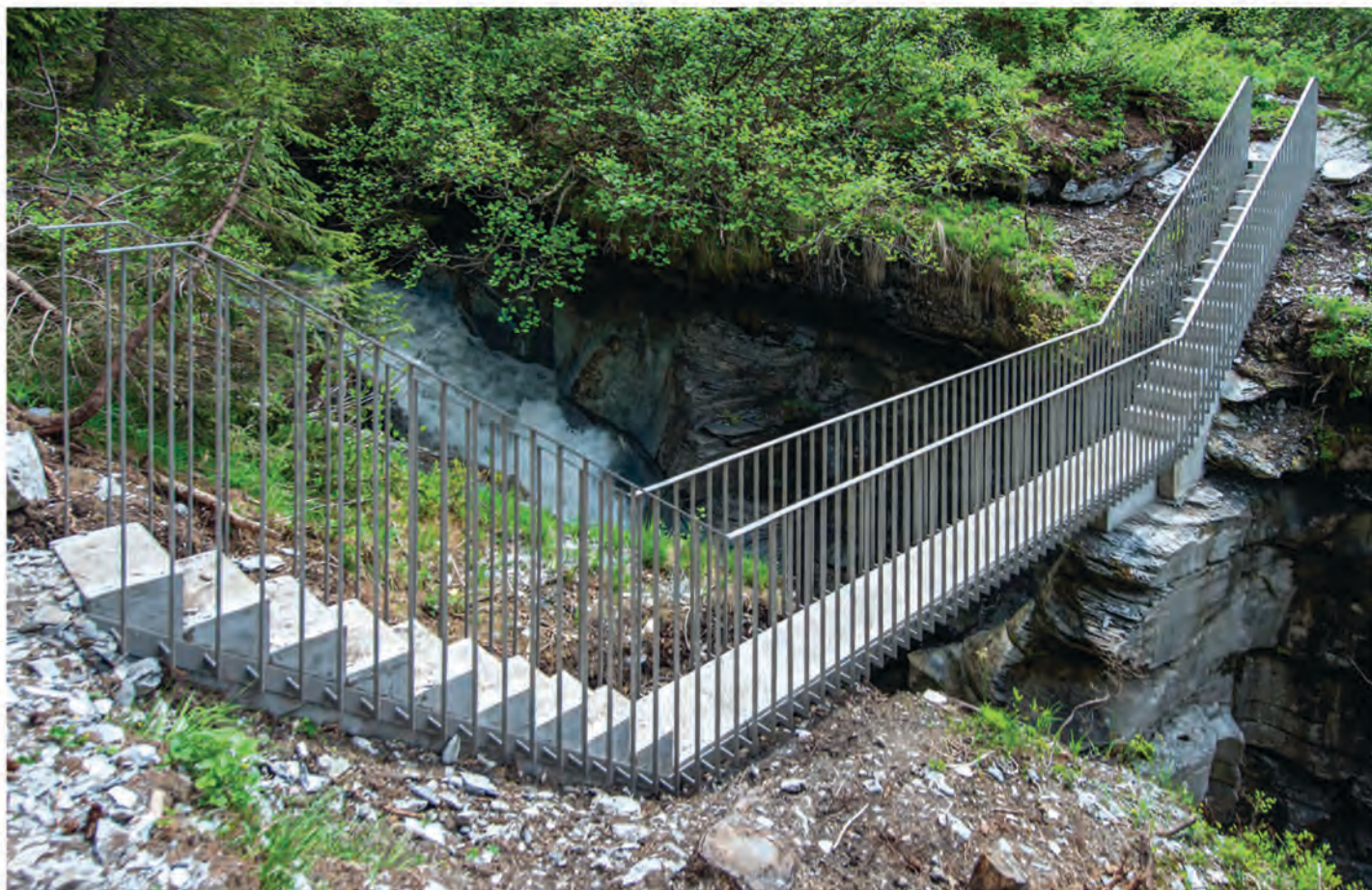
Eine der sieben ausserordentlichen Brücken des Flimser Wasserwegs, welche von Jürg Conzett realisiert wurden.
